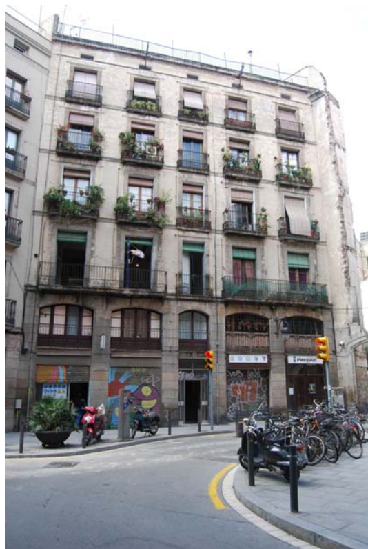
Fotografia núm. 1: exterior de l'edifici
