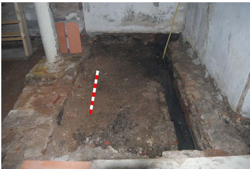
Fotografia núm. 8: rebaix a l'interior del local
