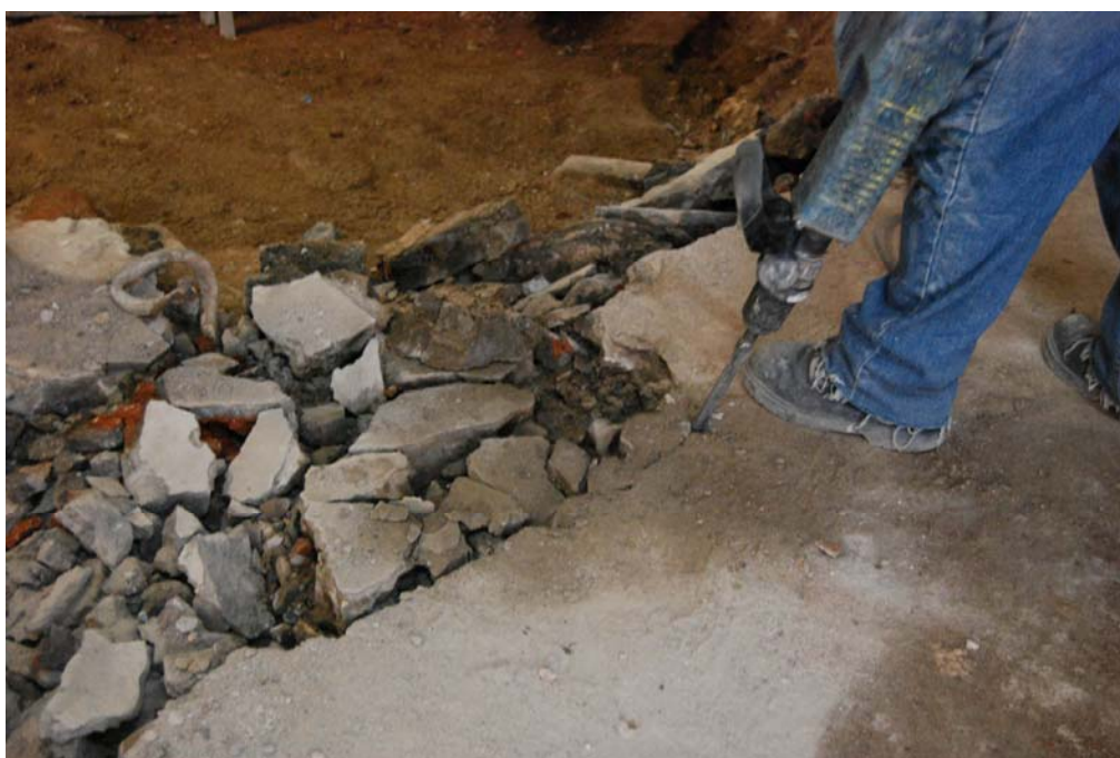
Fotografia núm. 6: desmantellament del paviment
